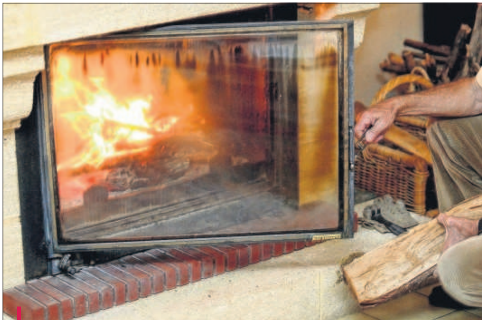
Seules les cheminées à foyer fermé par un insert ou un poêle performant, c'est-à-dire doté d'un bon rendement énergétique, sont autorisées.
